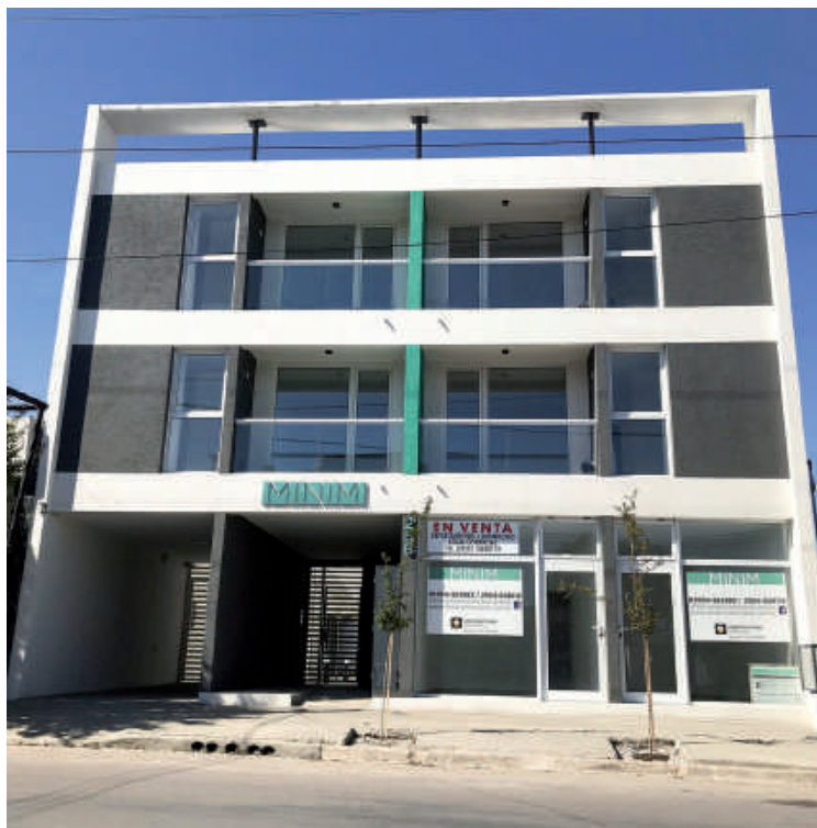
Imponente frente del Edificio MINIM® de la calle Córdoba 256.
