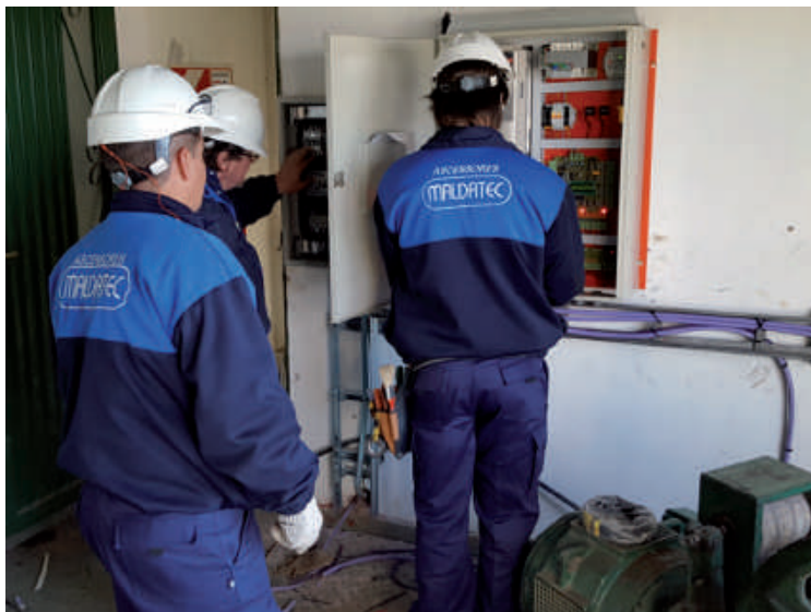
Obra en la Central Hidroeléctrica “El Chocón”.
