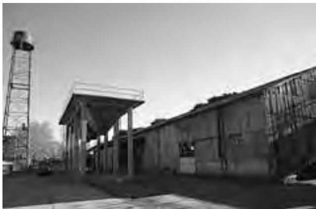
Está previsto el desmantelamiento de los galpones.
