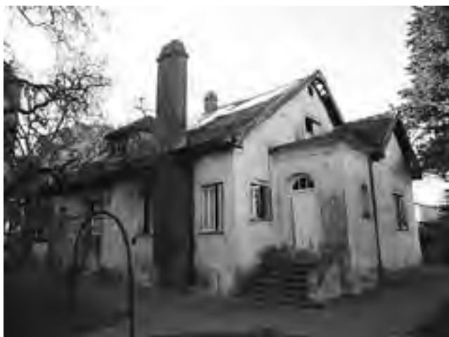
El antiguo chalet se remodelará para Casa de Té o eventos.
