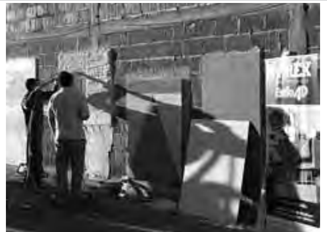
El PAREX ESTILO 4D, un mortero monocapa color de última generación destinado a la ejecución de fachadas, permite sustituir procesos tradicionales de azotado hidrófugo, revoque grueso, fino, textura y color en una única aplicación.
