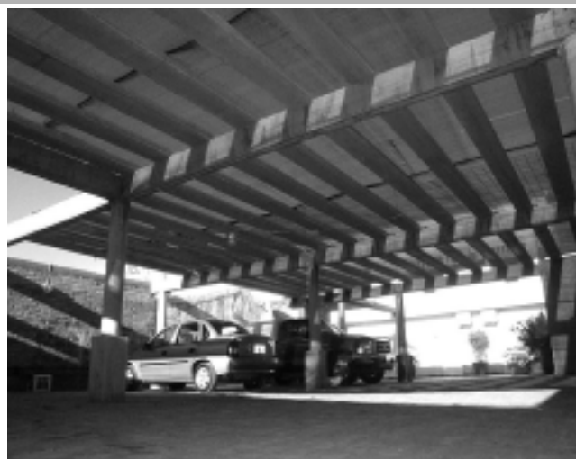
La cochera cubierta está a punto de terminarse y servirá de base para ampliar el apart hotel a 30 monoambientes y sala de convenciones.
