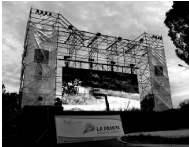
Dos camiones transportaron 16 toneladas de equipos, que se instalaron en el estacionamiento de la Terminal, frente a la Subsecretaría de Turismo.
