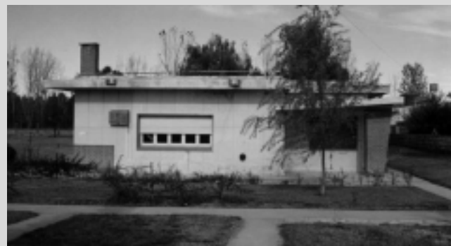
Primera construcción donde funcionó la Jefatura de Zona del EPRC. colonización de las tierras rurales ubicadas en el área susceptible de ser regada, proyectando y realizando por sí o por contratista, las obras de infraestructura previstas para el área, en los programas de desarrollo elaborados.»
