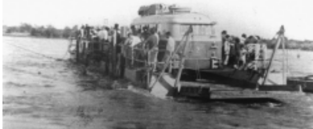
Antigua balsa con la que se cruzaba el Rio Colorado entre Catriel y 25 de Mayo, antes de la obra del Puente Dique Punto Unido.
