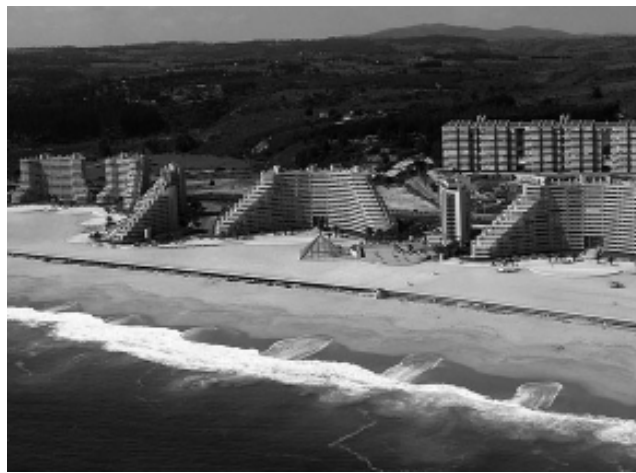
Es un gran complejo de departamentos con terrazas al mar, con la única piscina navegable del mundo, una obra de ingeniería que alberga a 250 millones de litros de agua en una superficie de 8 hectáreas. Cuenta con una playa bajo techo -única en Sudamérica- que tiene el agua climatizada, arena calefaccionada, camas con burbujas cascadas y masajes con chorros de agua.
