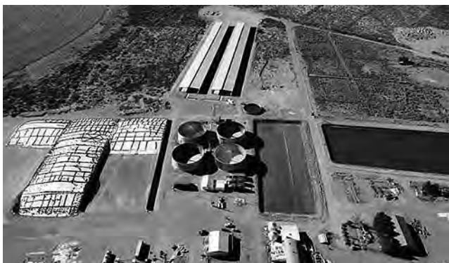
Antes de fin de año está previsto en 25 de Mayo poner en marcha la nueva Planta de Biogás con cuatro digestores que producirán biogás mediante la utilización de estiércol -bosta bovina- o elementos de forraje fermentados como pueden ser maíz, sorgo o similar.
