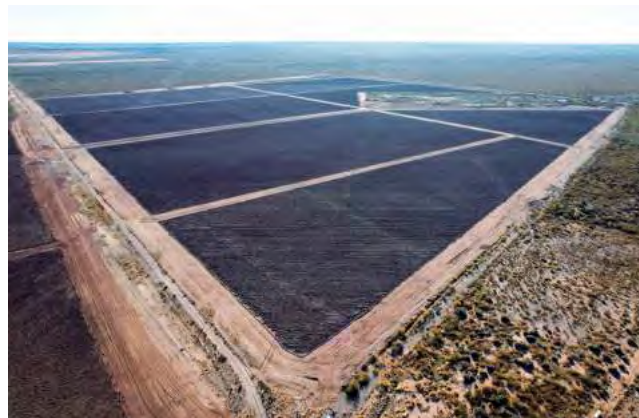
A la fecha, la superficie adquirida por la CFLP se encuentra completamente desmontada y subsolada. En paralelo, se han demarcado las líneas de plantación y se está ejecutando la instalación del sistema de riego.
