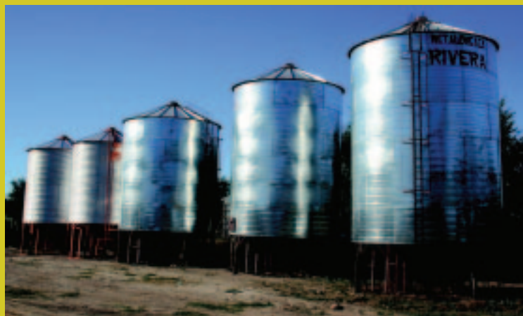
Batería de silos aéreos compuesta por 2 silos para fertilizante y 3 silos para semilla, adquiridos este año con préstamo A.C.E.S. obtenido de la Provincia de La Pampa a través de la Subsecretaría de Cooperativas.
